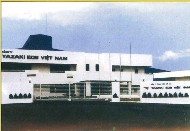
◀ NHÀ MÁY YAZAKI EDS VIETNAM Lắp đặt hệ thống ĐHKK Packaged Yazaki Eds Vietnam Harness Factory Install Packaged Air Conditioning
