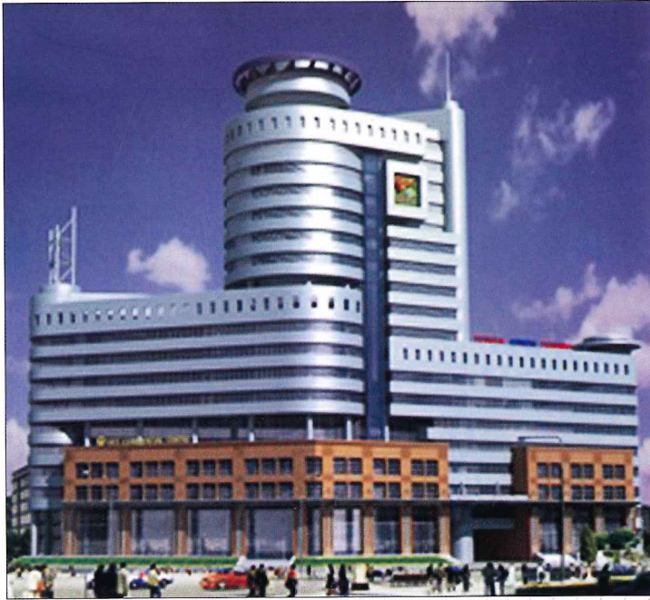
TÒA NHÀ THÁP VIỆT 189B TÂY SƠN Lắp đặt hệ thống ĐHKK
