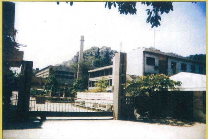
▶ NHÀ MÁY NHIỆT ĐIỆN NINH BÌNH Lắp đặt và bảo trì hệ thống ĐHKK Packaged Ninh Binh Themo - Electrical Plant Install and maintenance Packaged Air Conditioning
