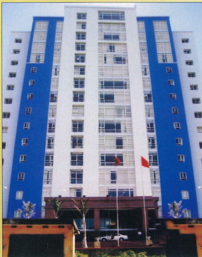
TRỤ SỞ LIÊN CƠ SỞ 2 UBND TỈNH QUẢNG NINH Cung cấp và lắp đặt hệ thống ĐHKK DAIKIN
