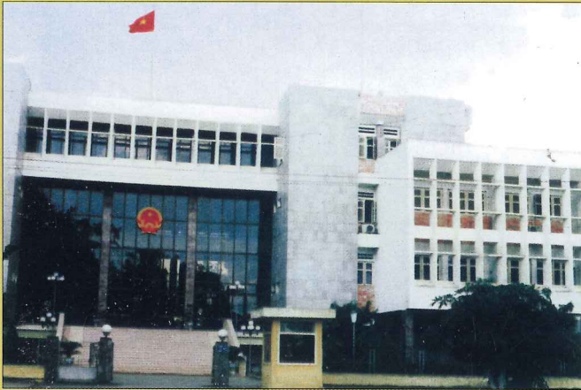
◀ TRỤ SỞ UBND TỈNH LẠNG SƠN Lắp đặt hệ thống ĐHKK People's Committee Office of Lang Son Province Install Air Conditioning
