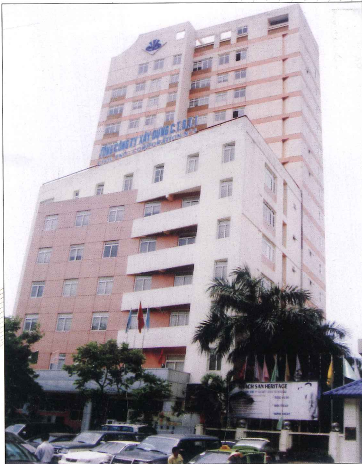
TRỤ SỞ TỔNG CÔNG TY CÔNG TRÌNH GIAO THÔNG 1 Cung cấp, lắp đặt hệ thống ĐHKK TOSHIBA-CARRIER
