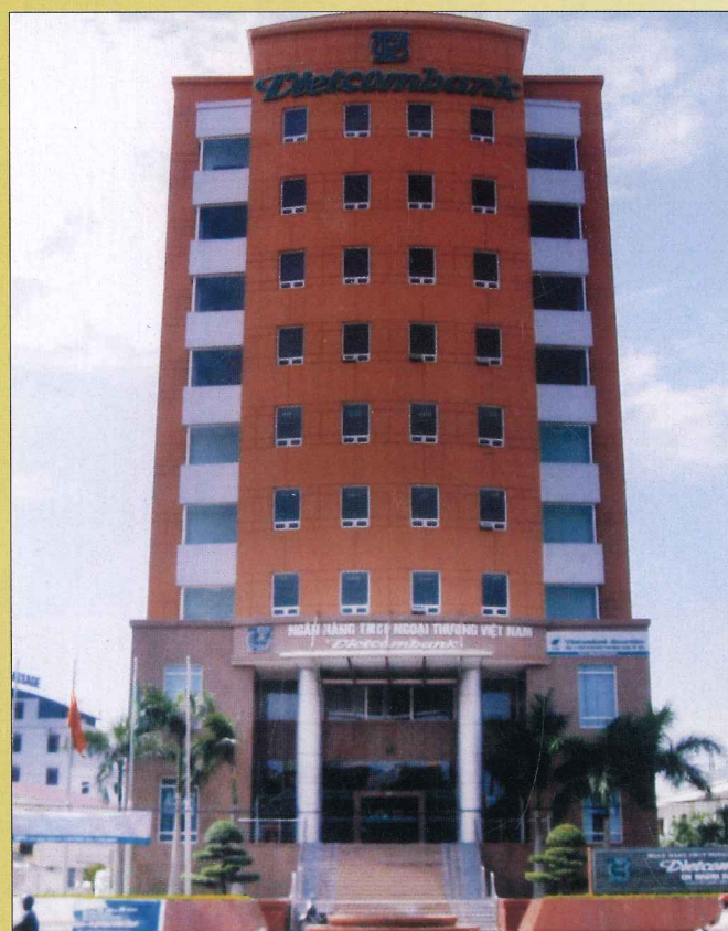
CHI NHÁNH NGÂN HÀNG VIETCOMBANK HẢI DƯƠNG Cung cấp, lắp đặt hệ thống ĐHKK TOSHIBA-CARRIER
